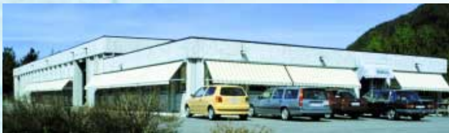
NORSOL fabrikk- og administrasjonsbygg, Saghøgda Tingvoll
